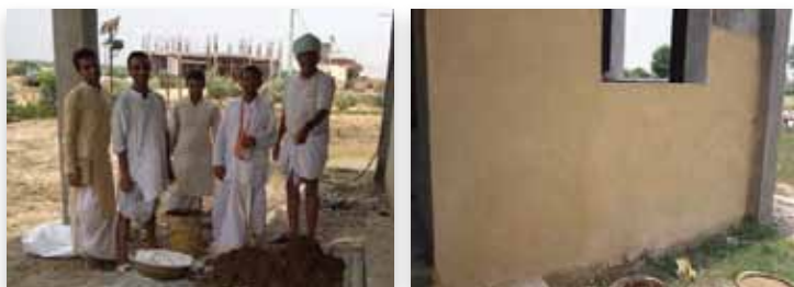
Fig 5,6 : Plastering at site
